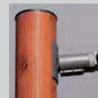
armaturet monteres direkte på masten
