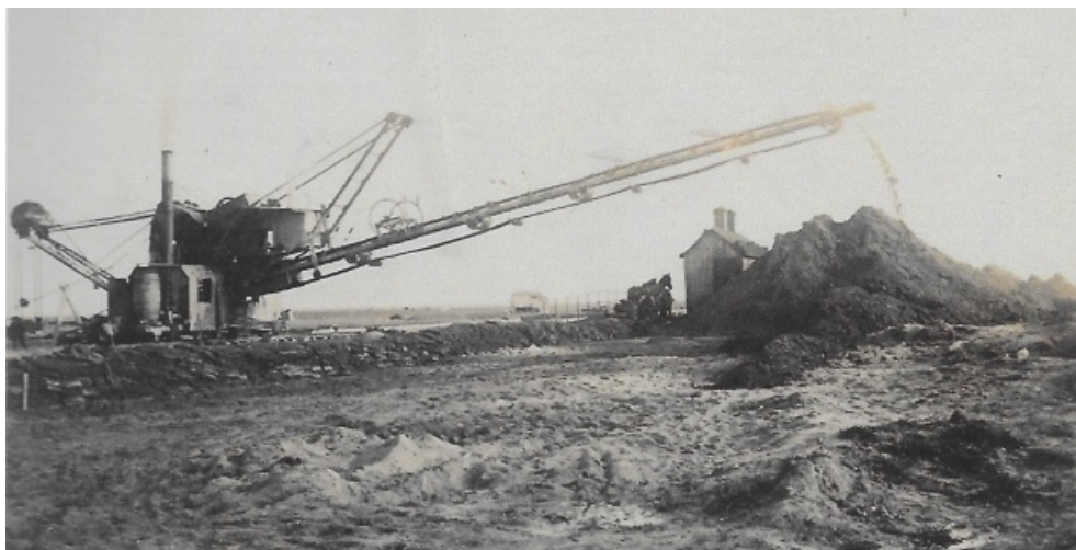
En af gravemaskinerne (med spande) der blev brugt ved arbejdet med Ribe diget 1911-1914. (Foto: Darum Sognearkiv)
